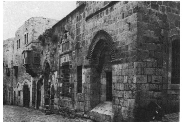
arch of conduit (?) ▲
